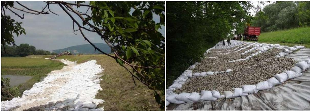
Abbildung 22: Auflastfilter aus Sandsäcken (links, Quelle: viadonau-HELMREICH) und kombiniert (rechts, Kombination aus Effizienzgründen und zur Befestigung des Vlieses, Quelle: viadonau-STEINER)
