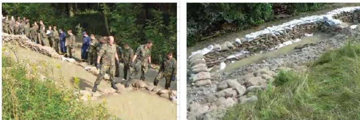
Abbildung 25: Fangedamm (oder „Quellkade“) für punktuelle oder stärkere Wasseraustritte aus der luftseitigen Böschung, (Quelle Bildmaterial: Kreisbrandinspektion Erding)
