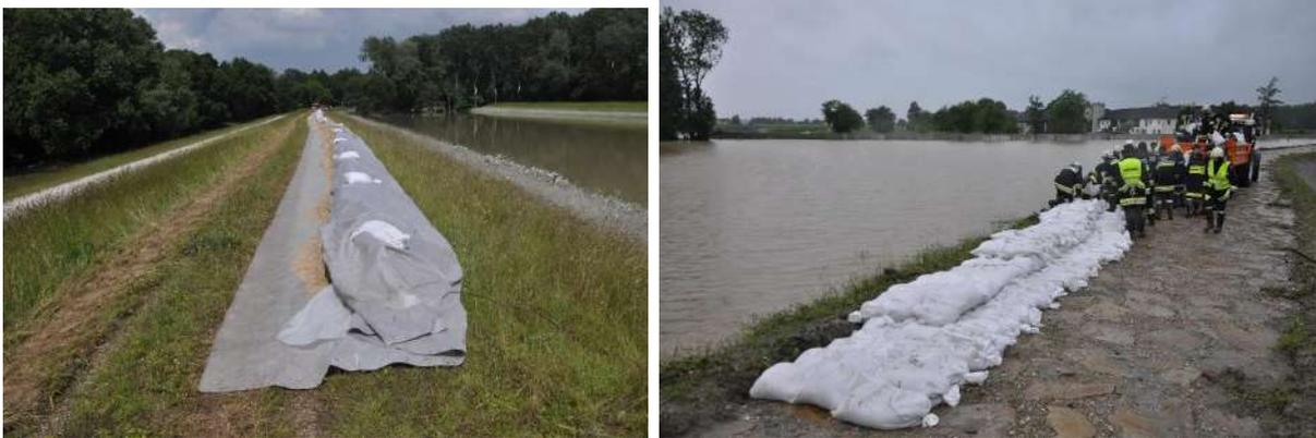
Abbildung 32: Dammerhöhung mit Kiesschüttung (links, Quelle: viadonau - SCHEURINGER), Dammerhöhung mit Sandsäcken (rechts, Quelle: FF Baumgartenberg)
