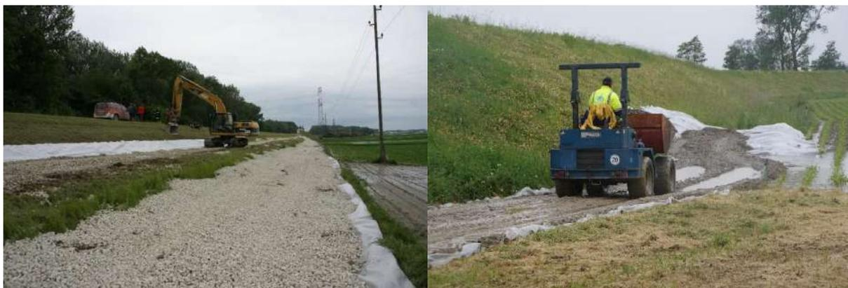
Abbildung 19: Auflastdrain durch Kiesschüttung (maschinell), Quelle: Presseteam BFKDO Gänserndorf (links), FF Baumgartenberg (rechts)
