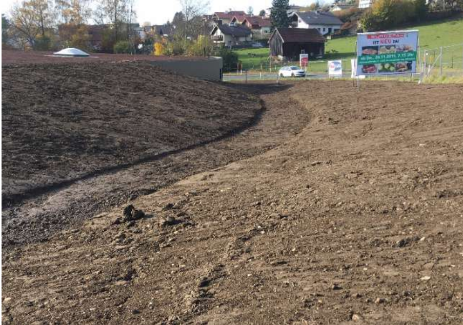
Abbildung 1: Mulde zum Vorbeileiten von Hangwasser am Objekt (Quelle: F. Weingraber)
