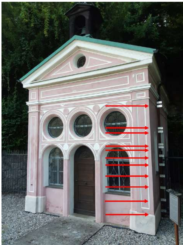
Abbildung 6: Hochwassermarken der Salzach. Das größte Ereignis wurde an dieser Stelle im Jahr 1899 registriert
